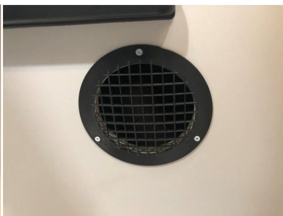
Bouche d'aspiration de l'air froid
